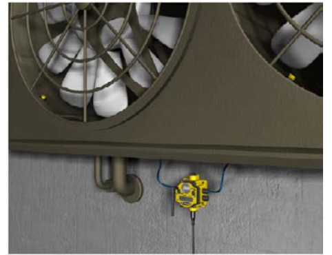
空调风机转速检测，控制送风量
